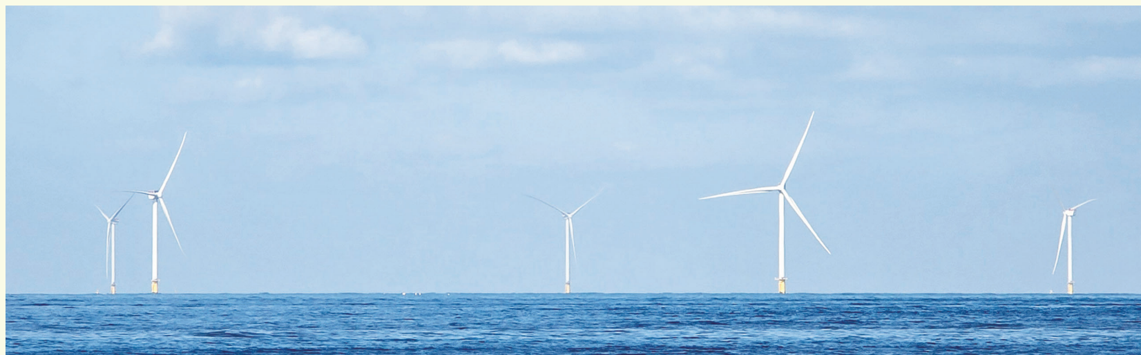
신안군 자은도 북서쪽 9km 해역의 '전남해상풍력 1단지'.
