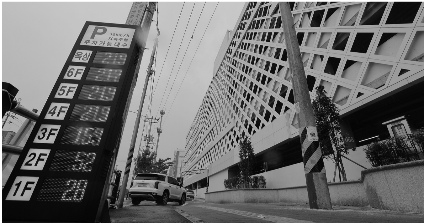
‘1580대 주차’ 광주송정역 주차빌딩 개장 광주송정역 인근에 주차빌딩이 완공됐다. 1580면 규모인 주차빌딩은 2015년 호남고속철도(KTX) 개통 이후 심각한 주차난의 해소를 위해 지어졌다. 이용 요금은 기본 30분에 1500원, 10분당 500원의 추가 요금이 부과되며 30분 내로 회차할 경우 무료다. 나건호 기자
