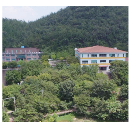
목포시청소년수련원 해 선정된다. 목포시청소년수련원은 이번 평가까지
