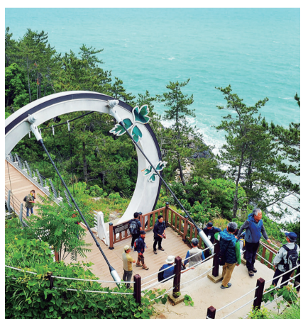
남면 금오도 3코스에 설치된 출렁다리
