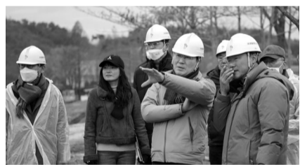
재단법인 순천만국제정원박람회조직위원회가 2023정원박람회 개막 50여일을 앞두고 박람회장 전체 공사 현장에 대한 특별안전 점검을 실시했다. 순천시 제공
