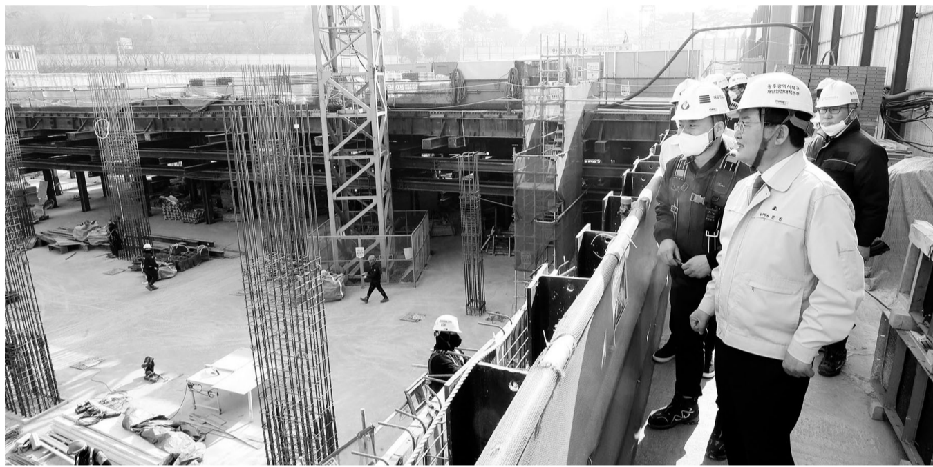
‘해빙기 안전사고 예방’ 건설현장 점검
