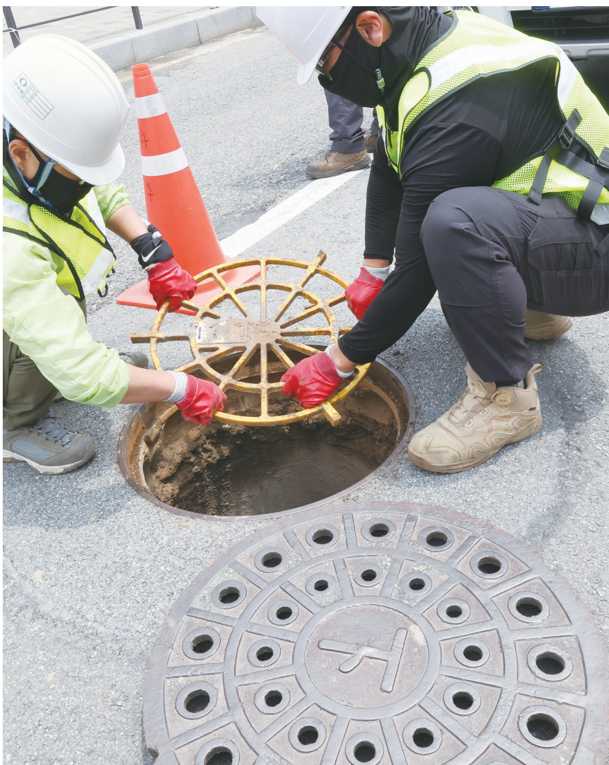
맨홀 점검 광주 북구청 하천방재과 하수팀 직원들이 17일 장마철을 앞두고 북구청 교차로에서 전대정문 구간에 설치된 맨홀 추락방지 안전망 점검을 하고 있다.
