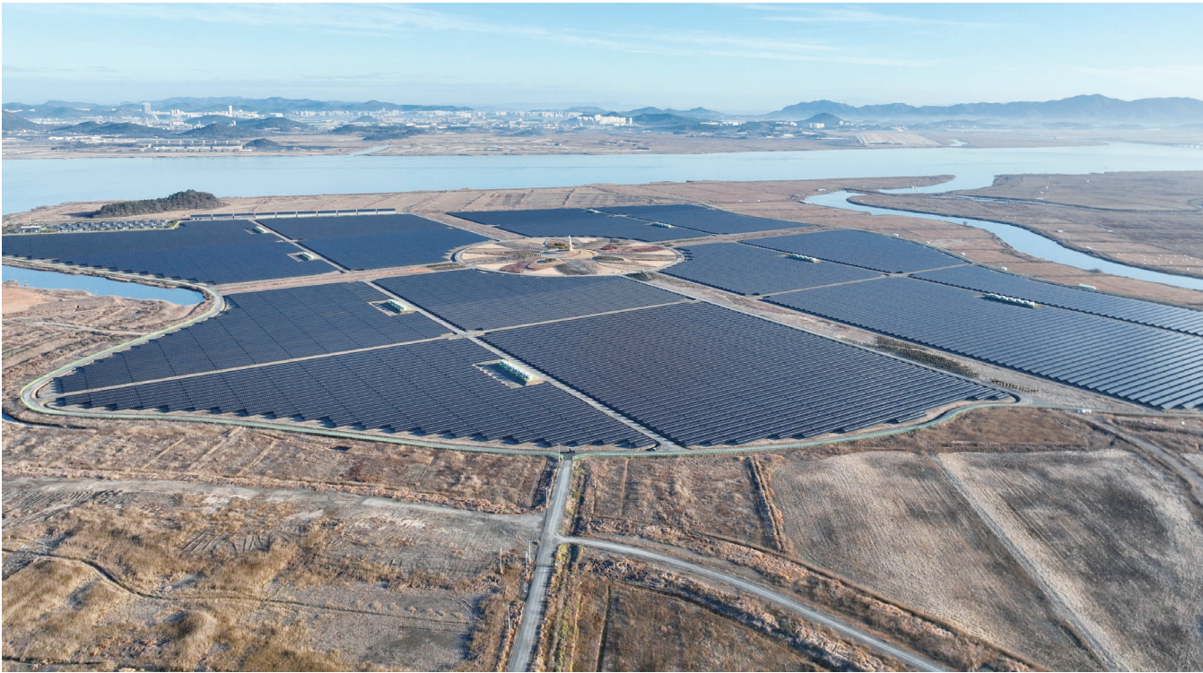
해남군 솔라시도 기업도시 일원에 조성된 태양광 발전소.
