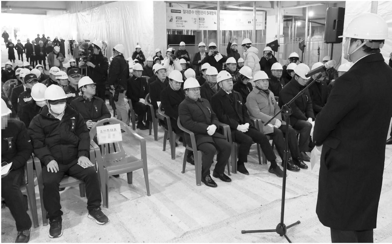
화정아이파크 붕괴 사고 3주기 추모식이 열린 지난 11일 광주 서구 화정동 사고 현장에서 유가족 대표가 희생자들의 안타까운 죽음을 잊지 않고 기억해야 된다고 강조하고 있다. 김양배 기자
