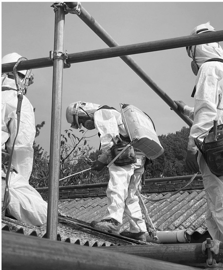
함평군 관계자들이 슬레이트 지붕을 개량하기 위해 습윤 작업을 하고 있다. 함평군은 기초생활수급자, 차상위계층, 취약계층에 대해서는 슬레이트 철거 비용 전액을 지원할 방침이다
