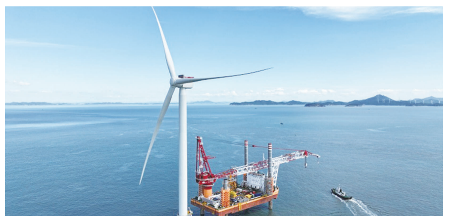
신안군이 자은도 해상에 96MW 해상풍력 발전기 10기를 설치 완료하고 올해 상반기 상업운전을 시작한다. 신안군 제공
