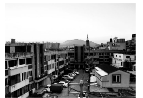
한진수 작 광천동 시민아파트 전경.
