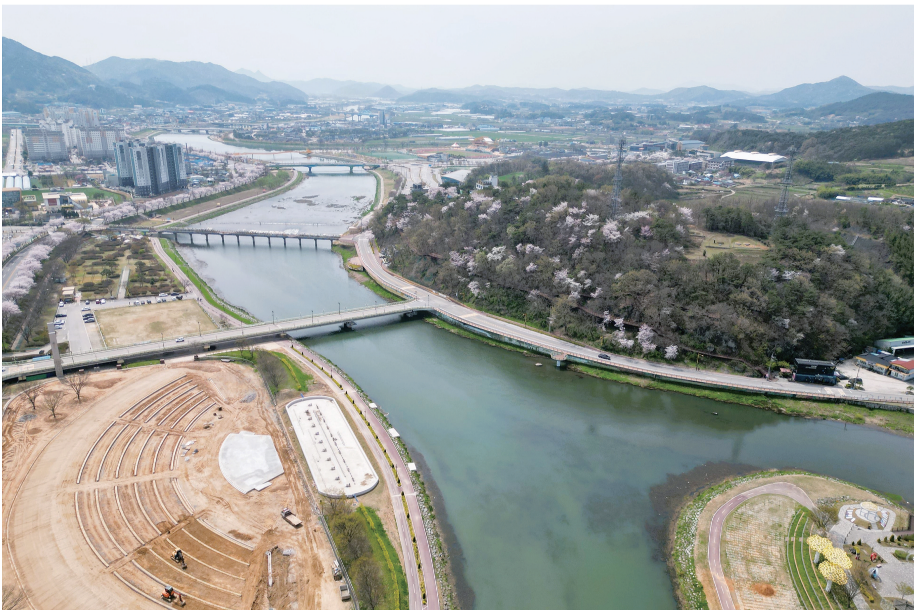
장성군(군수 김한중)이 오는 20~21일 진원 산동 유채꽃 축제를 비롯해 5월, 6월 열릴 각종 봄축제 준비에 구슬땀을 흘리고 있다. 장성 황룡강 전경. 왼쪽으로 조성 중인 황룡정원 잔디광장이 보인다. 오는 5월 길동무 꽃길축제 주무대다. 장성군 제공
