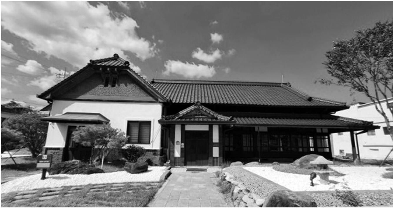
나주시에 일제강점기 근대 건축물을 리모델링한 ‘타오르는 강 박물관’이 내년 3월 개관한다.
