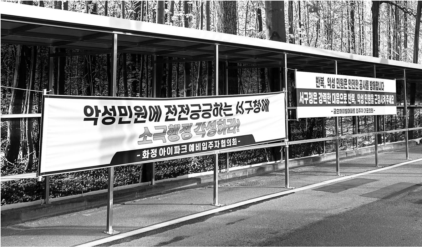
최근 화정아이파크 해체 공사 현장 펜스와 안전통행로에 악성민원이 공사를 방해한다는 내용의 현수막 20여개가 게시됐다.
